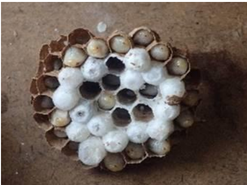
Nid primaire sur la poutre d'une véranda >>>
