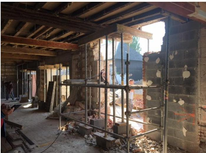
Le démontage des murs intérieurs a révélé la nécessité de travaux complémentaires en maçonnerie et charpente afin de consolider les murs et la toiture actuelle.
